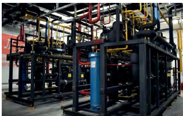
Рис. 1. Транскритические централи Elementum отечественного производства
